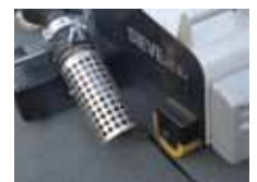
Soudage bitume modifié
